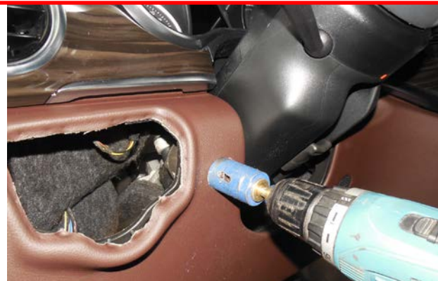
ФРЕЗА ДЛЯ МЕТАЛУ BF-43 Ø 30mm
